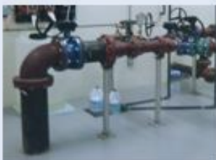
207 puits d'eau souterraine
