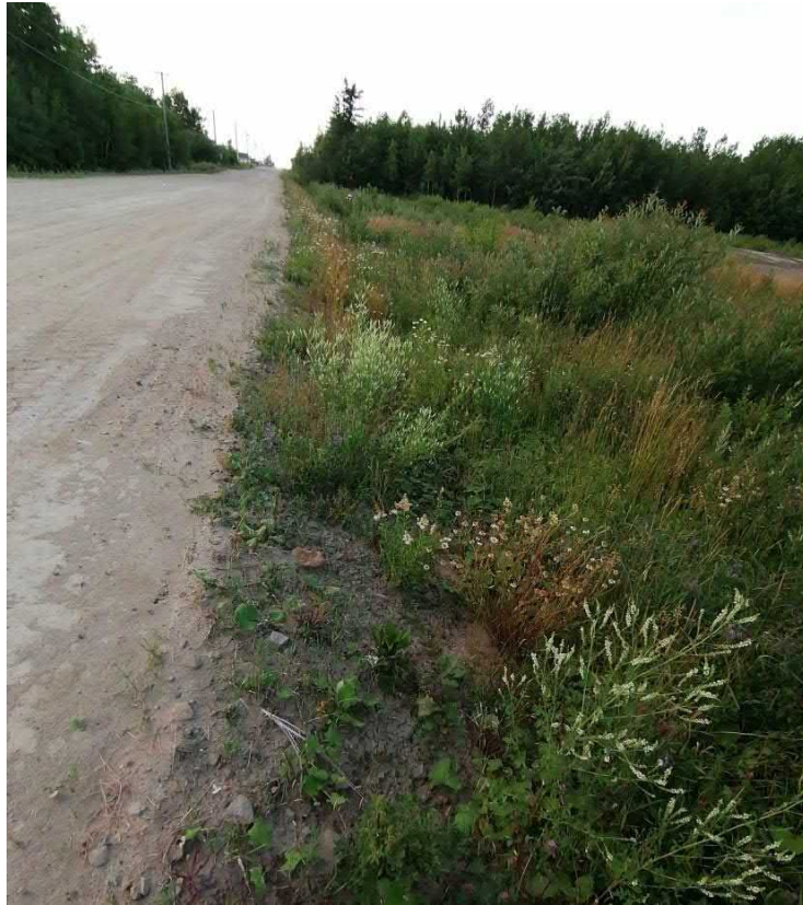
Photo 5 : Vue vers le nord du boulevard Industriel, montrant la dénivellation graduelle et constante du terrain depuis au-delà de la Véloroute.
