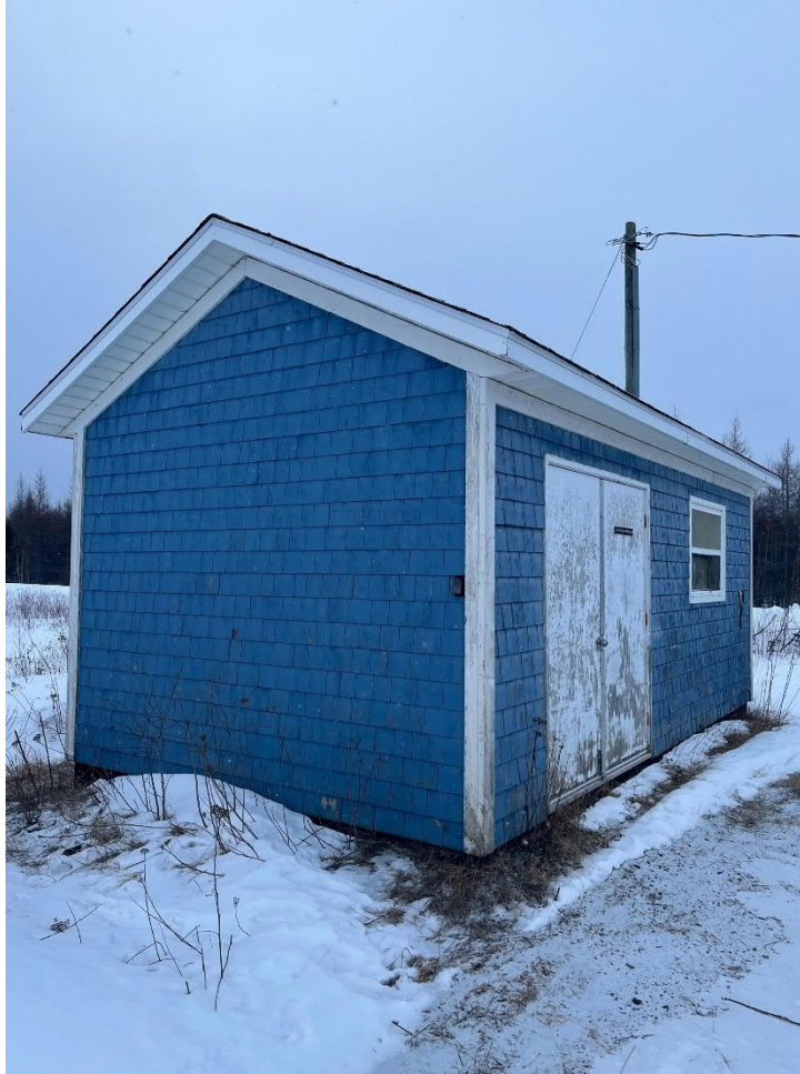
Image 5 : Station de pompage sur la propriété
