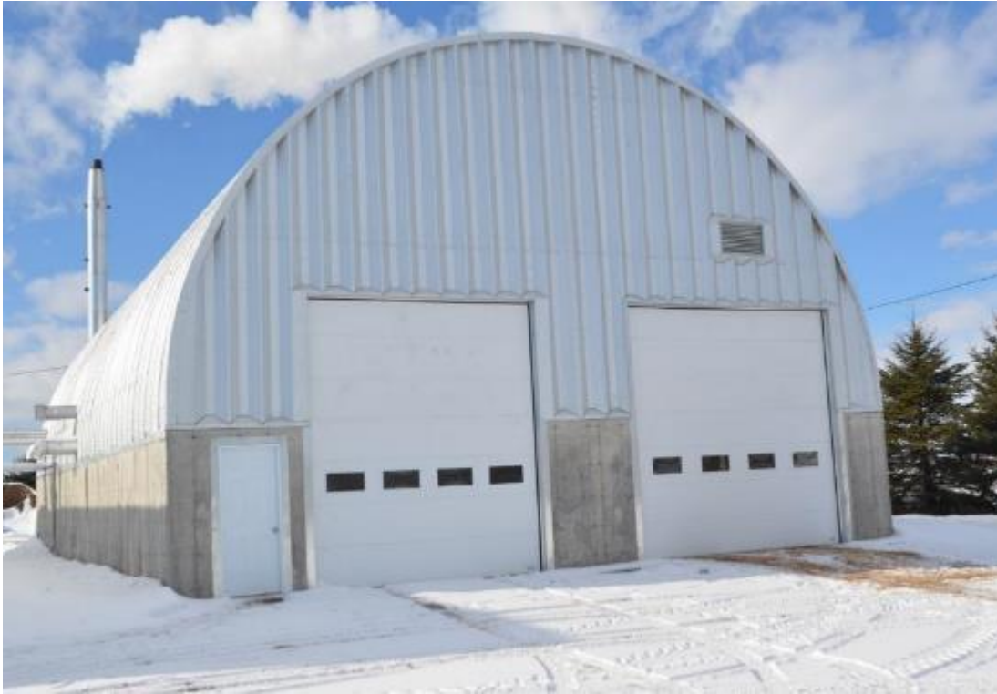
Bâtiment de chaufferie
