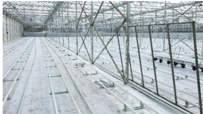
Rails au sol
