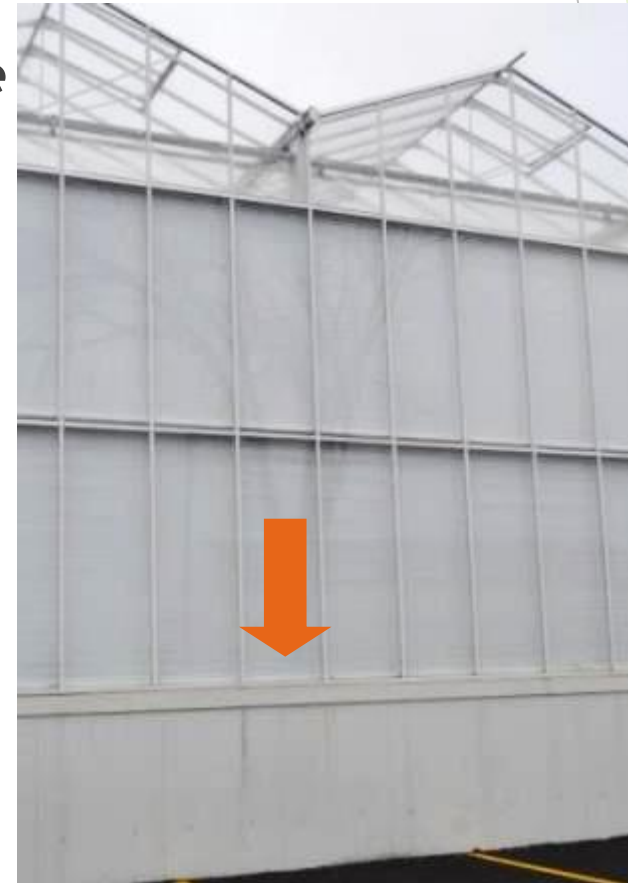
Muret d'isolation en panneaux Norlam 3''
