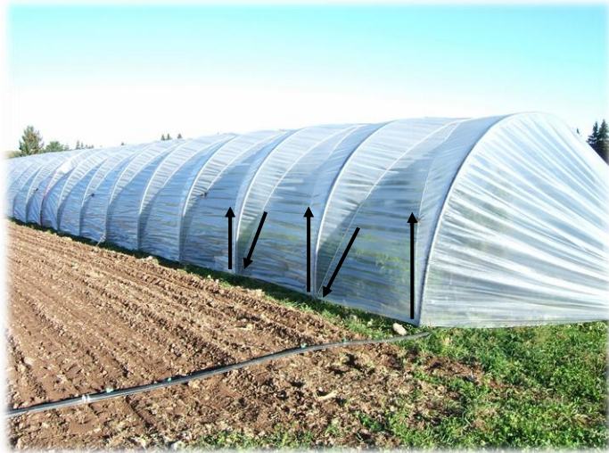
Vue des cordes de laçage
