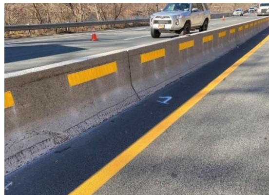
Barrière délimitée par des panneaux de balisage
