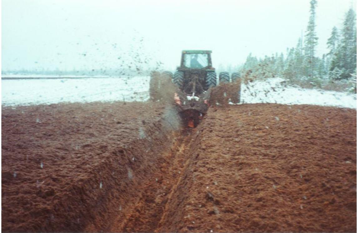
Creusage des canaux secondaires avec draineuse en V.
