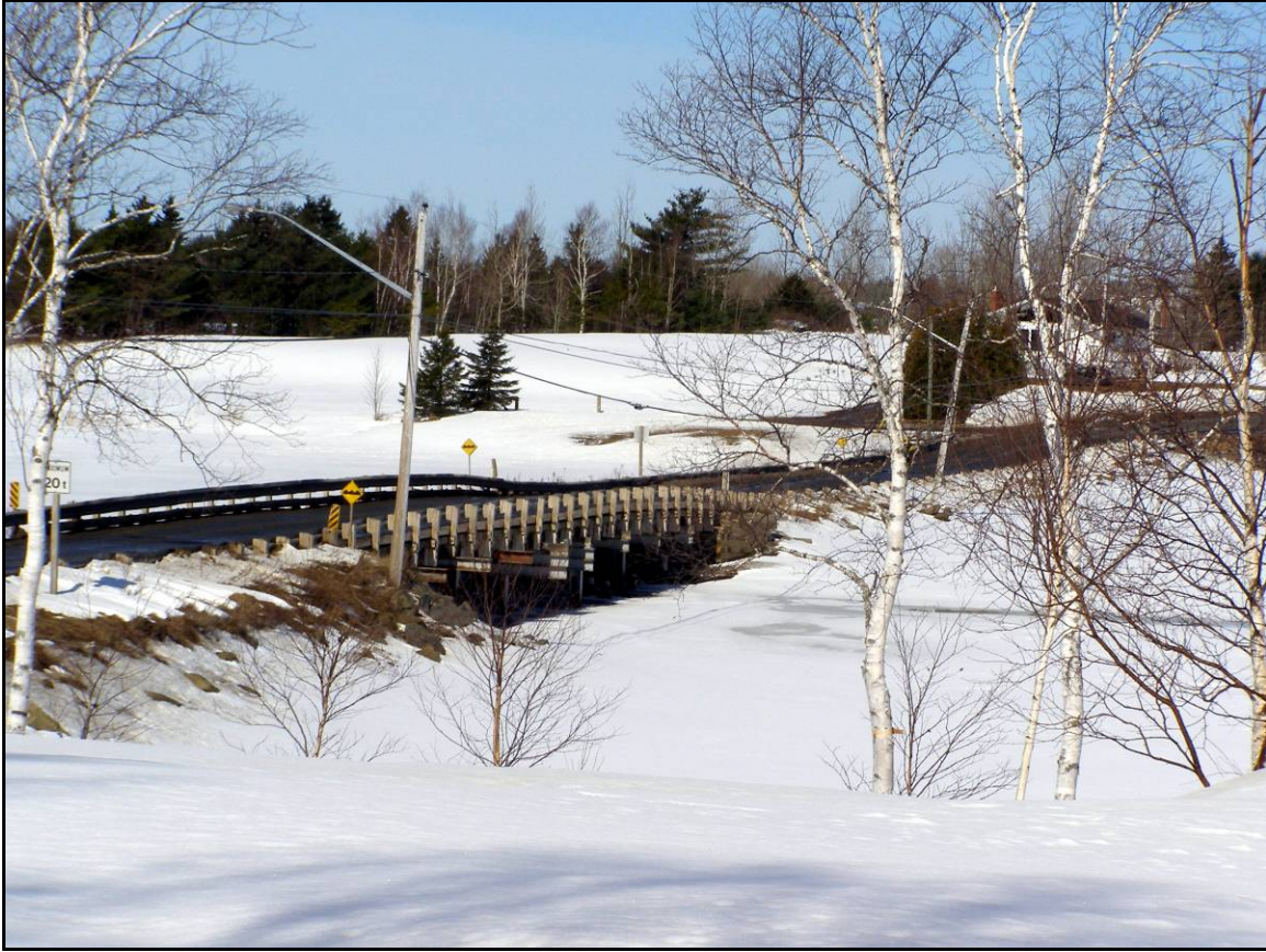
Little Tracadie River Bridge/ Pont d'Odilon (March 17, 2012)
