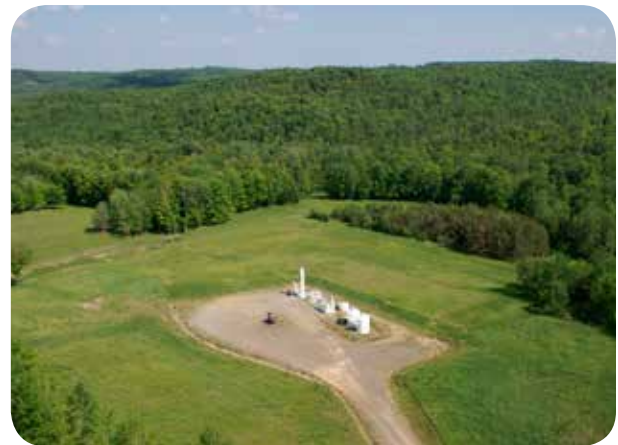
Puits et station de traitement du gaz opérationnels en Pennsylvanie (photo reproduite avec l'autorisation de Chesapeake Energy)
